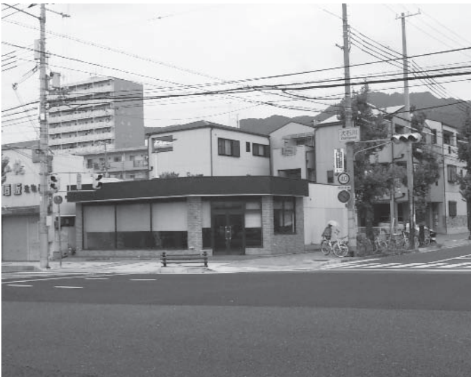
▲外観…建設予定地の灘南通1丁目のコンビニ跡。北側に2階建てを増築して使用する計画です。
