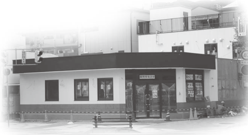
囲いが取れて外観がわかるようになった「小規模多機能とががわ」。 看板ももうすぐ設置されます。
